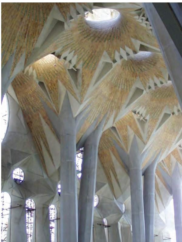
FIGURA 33. Conjunt de columnes i voltes de la nau central, generats per helicoides, hiperboloides i paraboloides.
