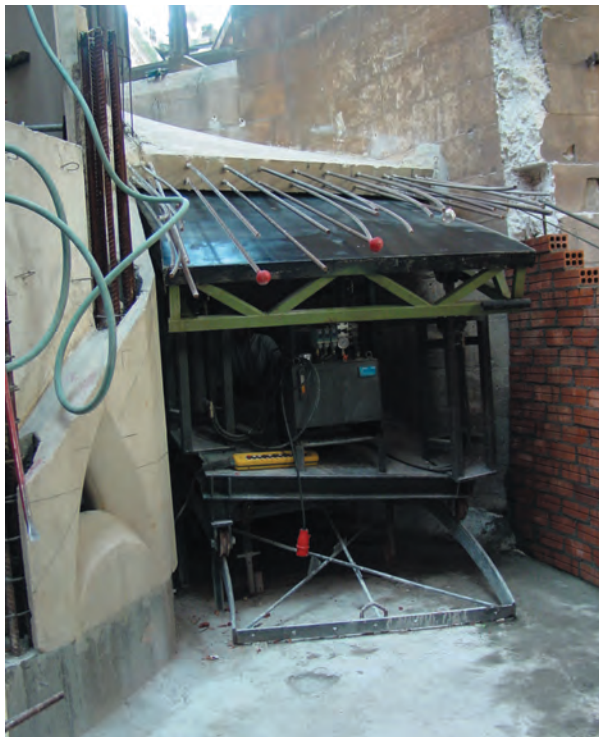
FIGURA 36. Encofrat mòbil per a la construcció d'un escala de cargol.
