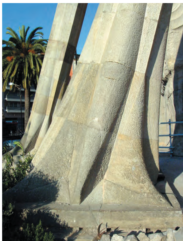
FIGURA 31. Base de les columnes del porxo de la façana de la Passió.
