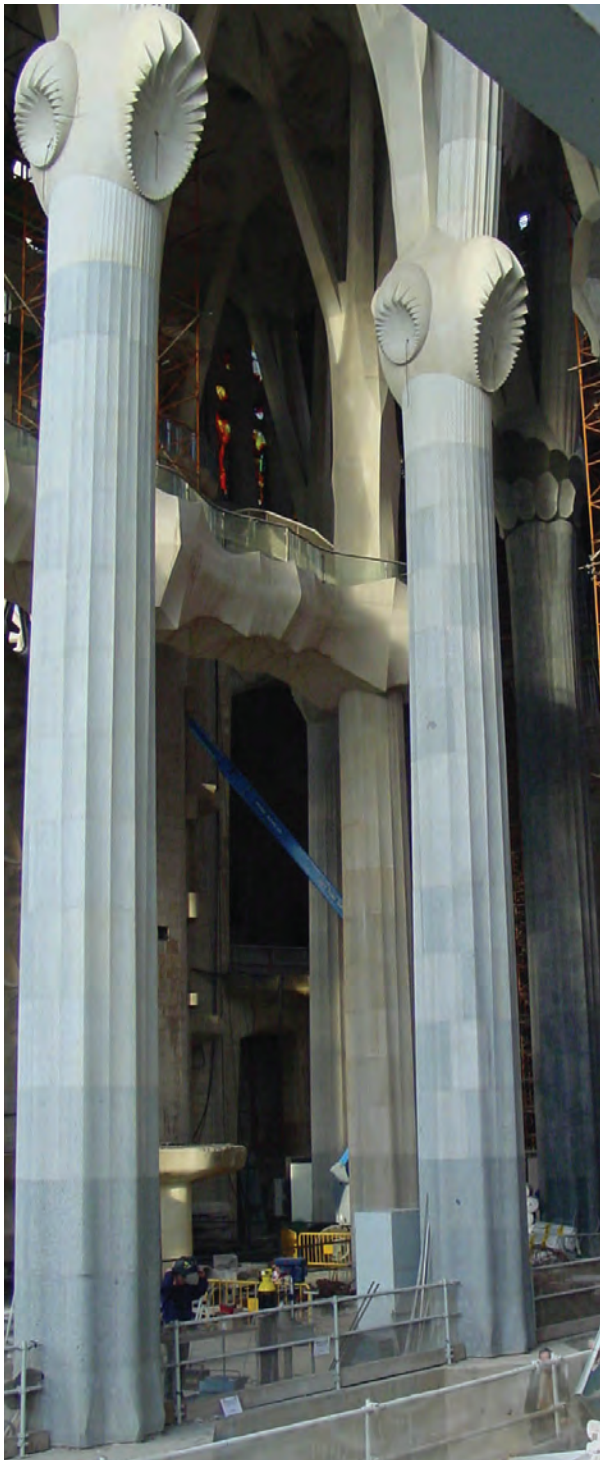
FIGURA 16. Dues columnes de la nau central, construïdes amb granit.
