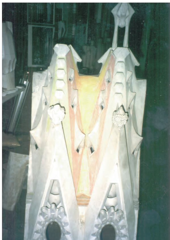
FIGURA 9. Model on es diferencien amb colors els diferents paraboloides que formen la coberta de la nau central.
